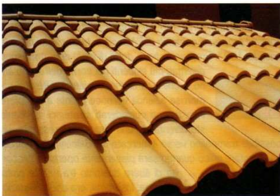
Example of roof covering consisting of Mixta (Portuguese) type tiles Esempio di copertura realizzata con tegole tipo Mixta (portoghese)
