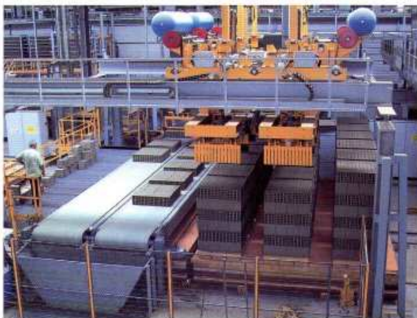
Scarico del materiale secco ed impilamento dei carri forno. Unloading of the dry material and stacking of the oven trolleys.
